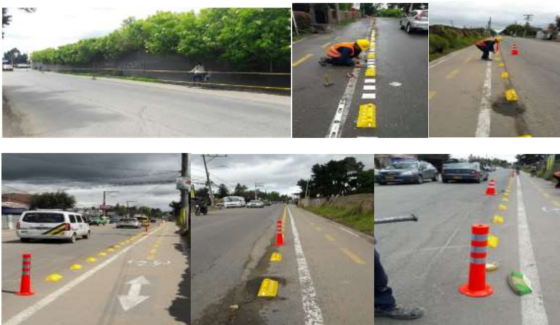
IMAGEN 88. CONSTRUCCIÓN CICLO RUTA VÍA GUAYMARAL DE CALLA 2 SUR A ENTRADA SUR SECTOR JUNTAS
