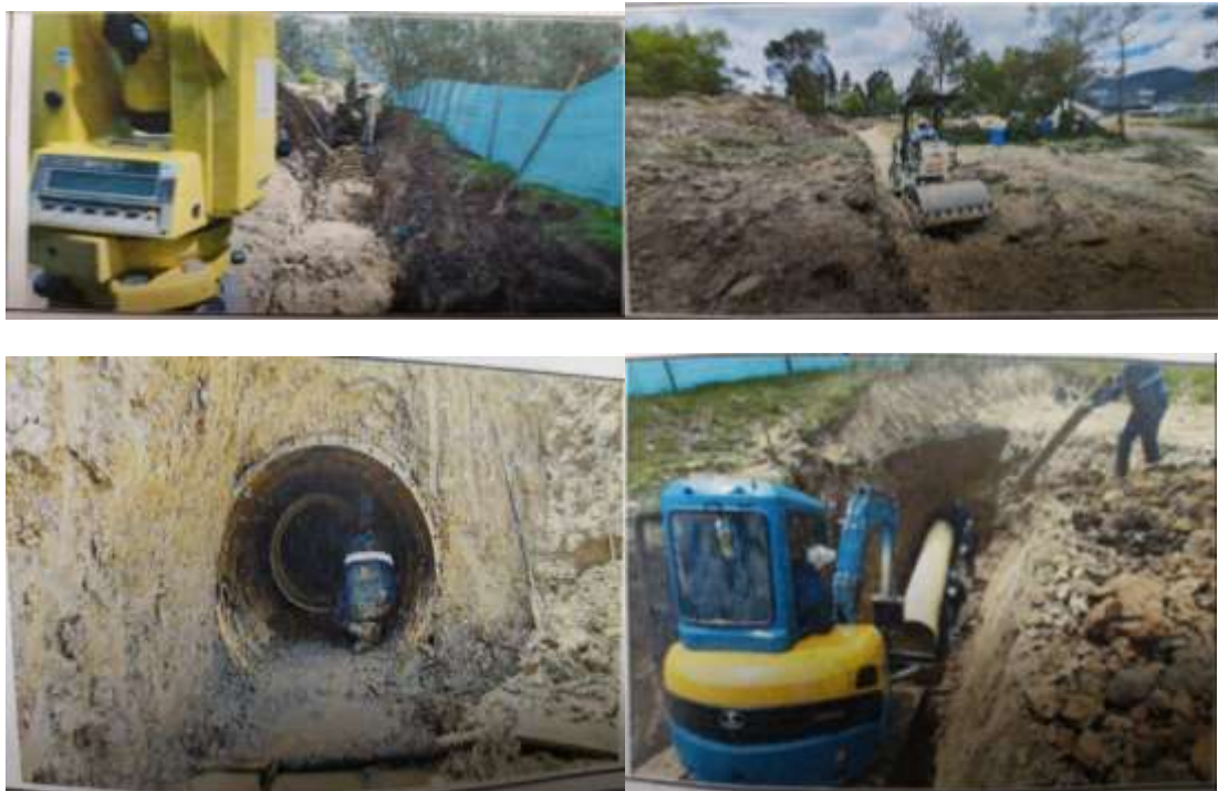
IMAGEN 128. CONSTRUCCIÓN COLECTORES MÁRGENES DEL RIO FRIO Y SISTEMA DE BOMBEO A LA PTAR CHÍA II.
