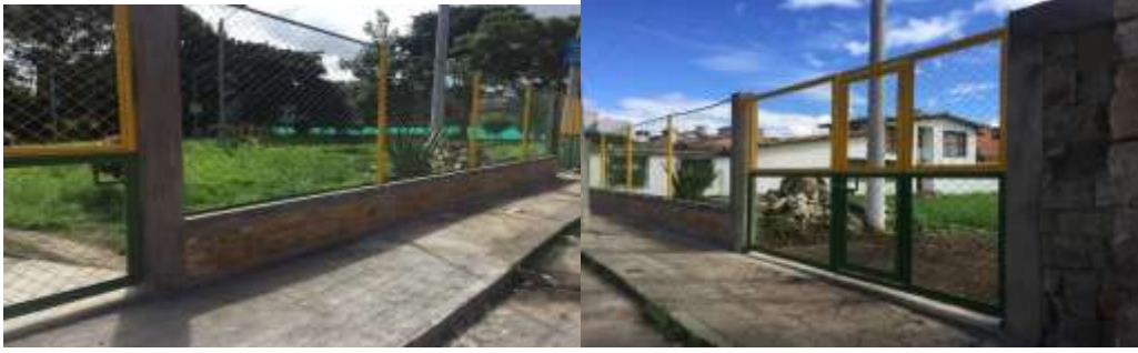
IMAGEN 96. CERRAMIENTO PREDIO COLEGIO FONQUETA
