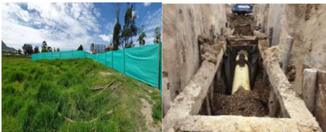
IMAGEN 127. CONSTRUCCIÓN COLECTORES MÁRGENES DEL RIO FRIO Y SISTEMA DE BOMBEO A LA PTAR SEGUNDA ETAPA CHÍA, CUNDINAMARCA, CENTRO ORIENTE
