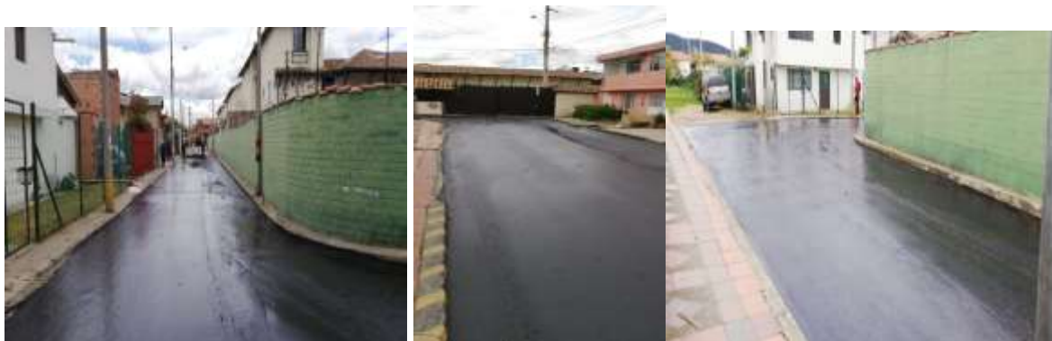
IMAGEN 84. SLURRY 1RA CAPA CRA 5 DE AV PRADILLA HACIA LA CALLE 19. SECTOR PATACOS. (257MT)
