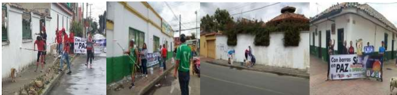
IMAGEN 131. RECUPERACIÓN DE FACHADAS
