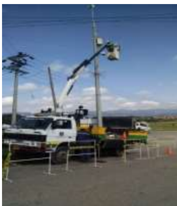
IMAGEN 137. MANTENIMIENTO DE CÁMARAS
