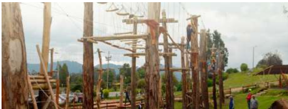
IMAGEN 142. VERIFICACIÓN REQUISITOS PARQUE TERRA MÁGICA
