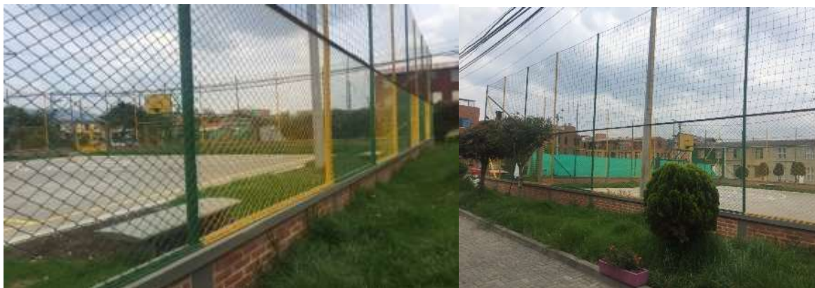
IMAGEN 91. CERRAMIENTO CANCHAS NUEVO MILENIO
