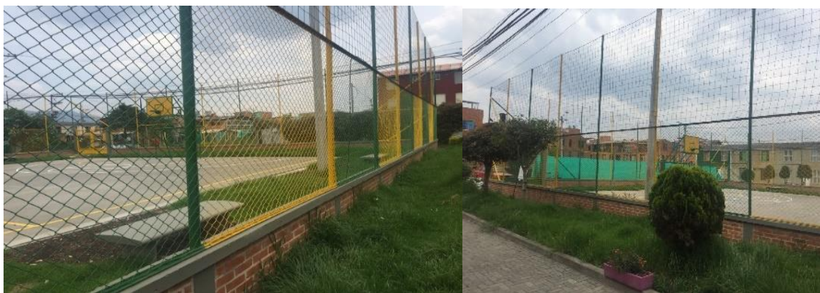
IMAGEN 91. CERRAMIENTO CANCHAS NUEVO MILENIO
