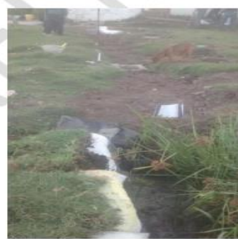
Vista completa del tratamiento, en la esquina inferior derecha se encuentra el humedal.
