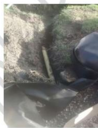
Entrada del agua residual al Humedal.
