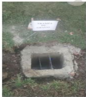
Trampa de grasas instaladas.
