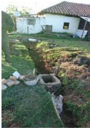
Conducción de aguas a trampa de grasas.
