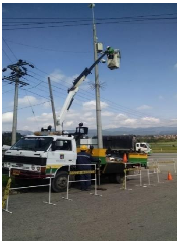
IMAGEN 137. MANTENIMIENTO DE CÁMARAS
