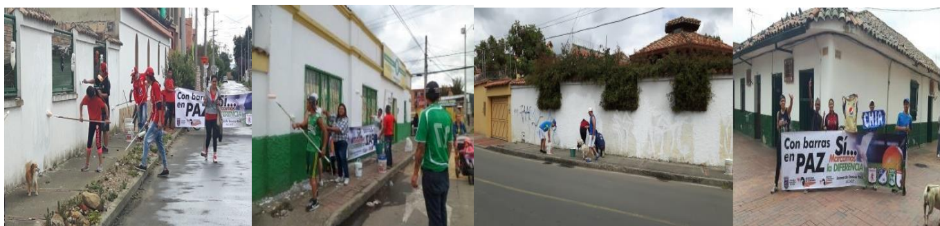
IMAGEN 131. RECUPERACIÓN DE FACHADAS
