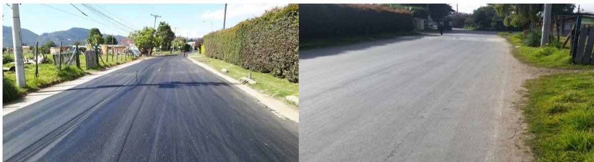
IMAGEN 84. SLURRY 1RA CAPA CRA 5 DE AV PRADILLA HACIA LA CALLE 19. SECTOR PATACOS. (257MT)
