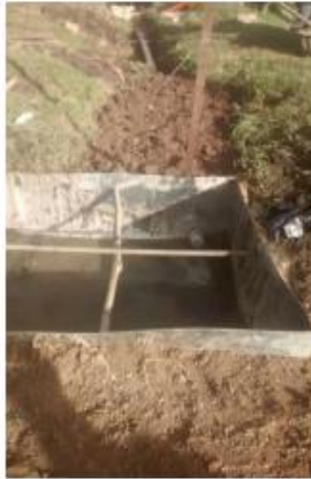
Tratamiento primario de retención de sólidos.
