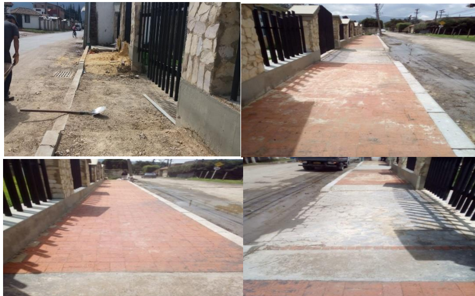
IMAGEN 106. CONSTRUCCIÓN DE ANDÉN FRENTE AL POLIDEPORTIVO EL NISPERO, CON BANCO DE MAQUINARIA, BANCO DE MATERIALES Y PERSONAL OPERARIO
