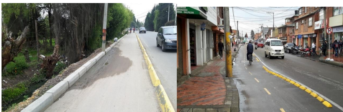
IMAGEN 83. MANTENIMIENTO DE CICLO RUTA: CARRERA 9 ENTRE CAMINO PUENTE PERALTA Y PARQUE OSPINA
