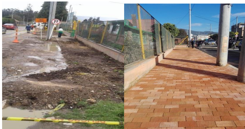
IMAGEN 101. CONSTRUCCIÓN DE ANDÉN FRENTE AL POLIDEPORTIVO EL NISPERO, CON BANCO DE MAQUINARIA, BANCO DE MATERIALES Y PERSONAL OPERARIO
