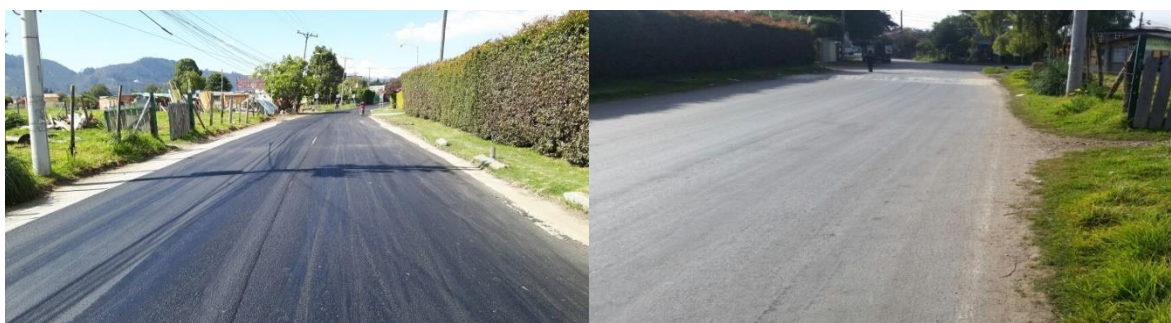
IMAGEN 81. SLURRY 1RA CAPA CRA 5 DE AV PRADILLA HACIA LA CALLE 19. SECTOR PATACOS. (257MT)
