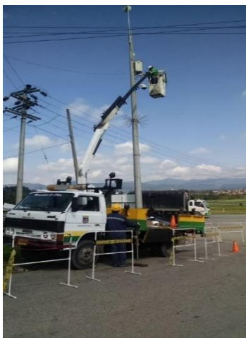
IMAGEN 131. MANTENIMIENTO DE CÁMARAS
