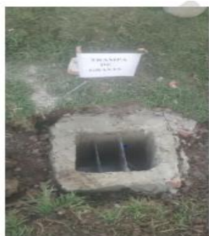
Trampa de grasas instaladas.
