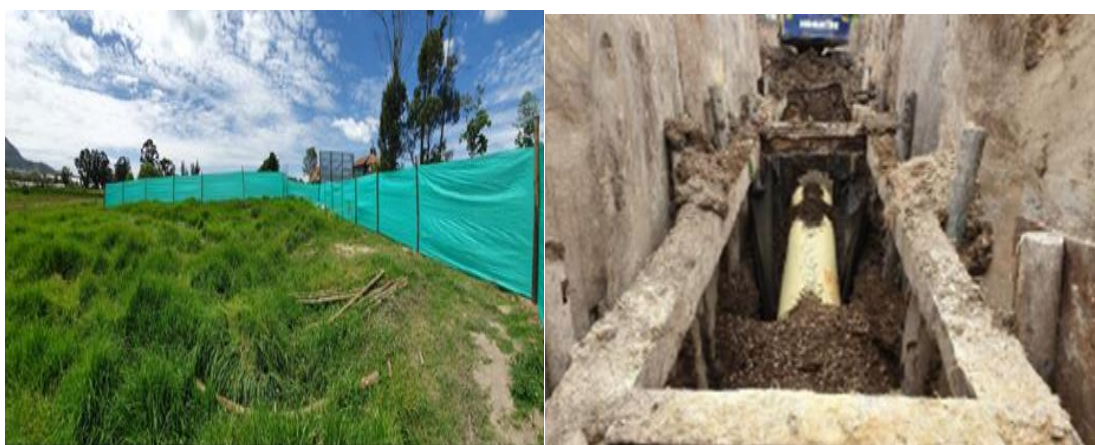
IMAGEN 122. CONSTRUCCIÓN COLECTORES MÁRGENES DEL RIO FRIO Y SISTEMA DE BOMBEO A LA PTAR SEGUNDA ETAPA CHÍA, CUNDINAMARCA, CENTRO ORIENTE
