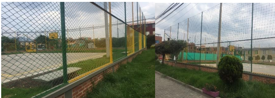
IMAGEN 87. CERRAMIENTO CANCHAS NUEVO MILENIO
