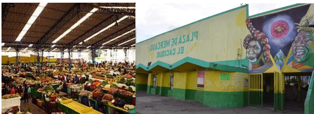
IMAGEN 61. MEJORAS INFRAESTRUCTURA PLAZA DE MERCADO
