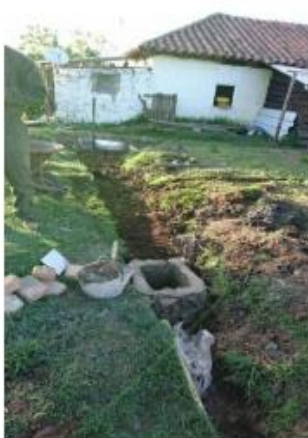
Conducción de aguas a trampa de grasas.
