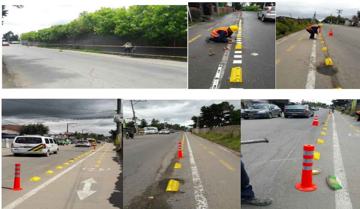
IMAGEN 85. CONSTRUCCIÓN CICLO RUTA VÍA GUAYMARAL DE CALLA 2 SUR A ENTRADA SUR SECTOR JUNTAS
