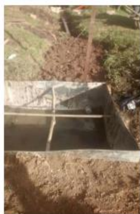
Tratamiento primario de retención de sólidos.
