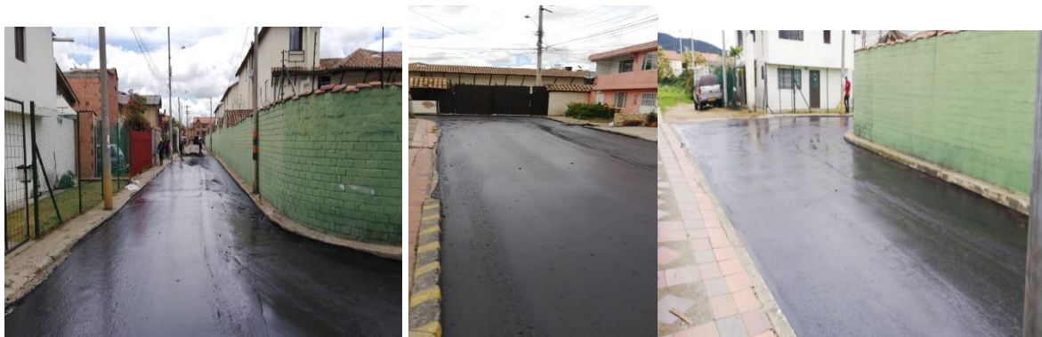
IMAGEN 81. SLURRY 1RA CAPA CRA 5 DE AV PRADILLA HACIA LA CALLE 19. SECTOR PATACOS. (257MT)
