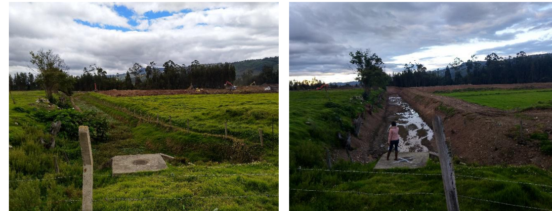
Condiciones antes y después de la intervención en el Vallado Samaria
