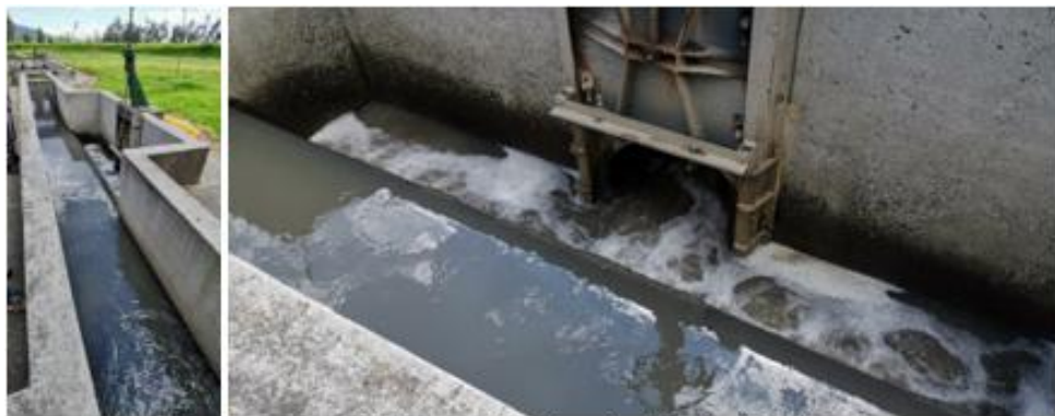
Diagnóstico Hidráulico y Operativo
