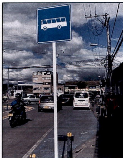
Imagen 79. Registro fotográfico paradero – Calle 13 (Parque Ospina)
