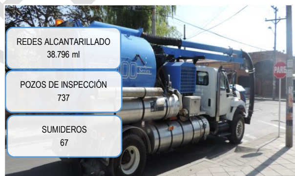
Ilustración 1. Mantenimiento de redes de alcantarillado, pozos y sumideros
