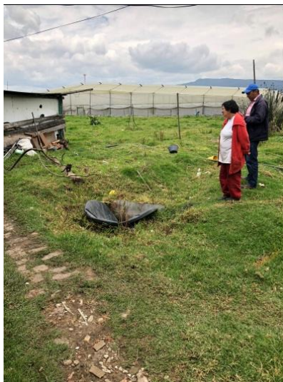
Adecuación de pozo
