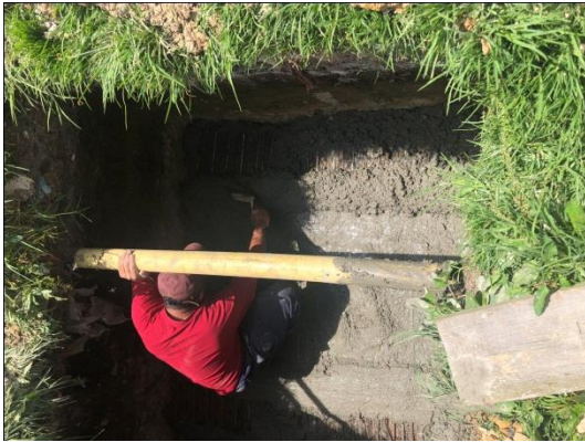
Construcción de trampa de grasas
