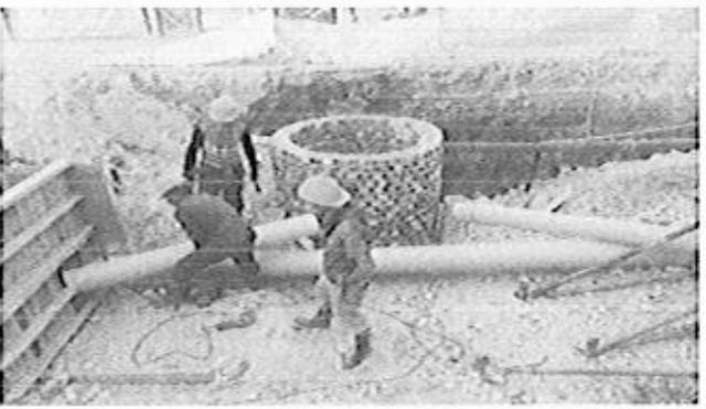
**13. TUBERÍA GRP 1600 MM PN6-SN 2500 E INSTALACIÓN TUBERÍA PLÁSTICA DIÁMETRO 1500 MM A 1700 MM.**
