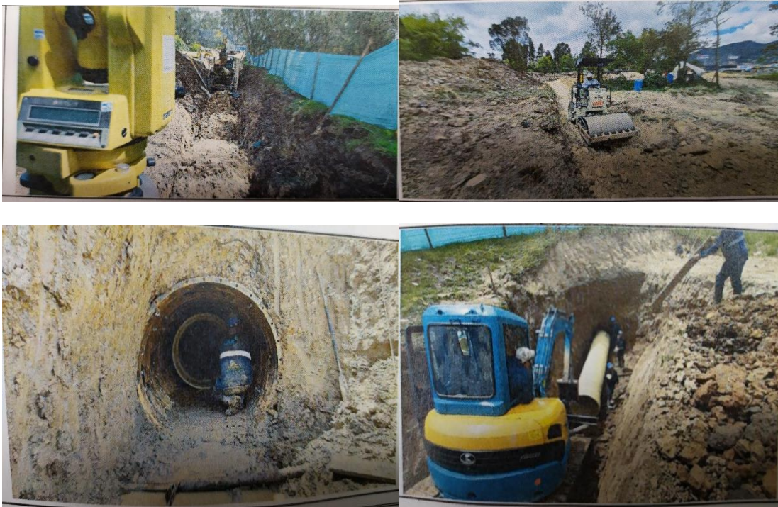
IMAGEN 123. CONSTRUCCIÓN COLECTORES MÁRGENES DEL RIO FRIO Y SISTEMA DE BOMBEO A LA PTAR II.
