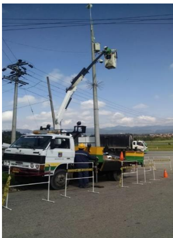
IMAGEN 131. MANTENIMIENTO DE CÁMARAS
