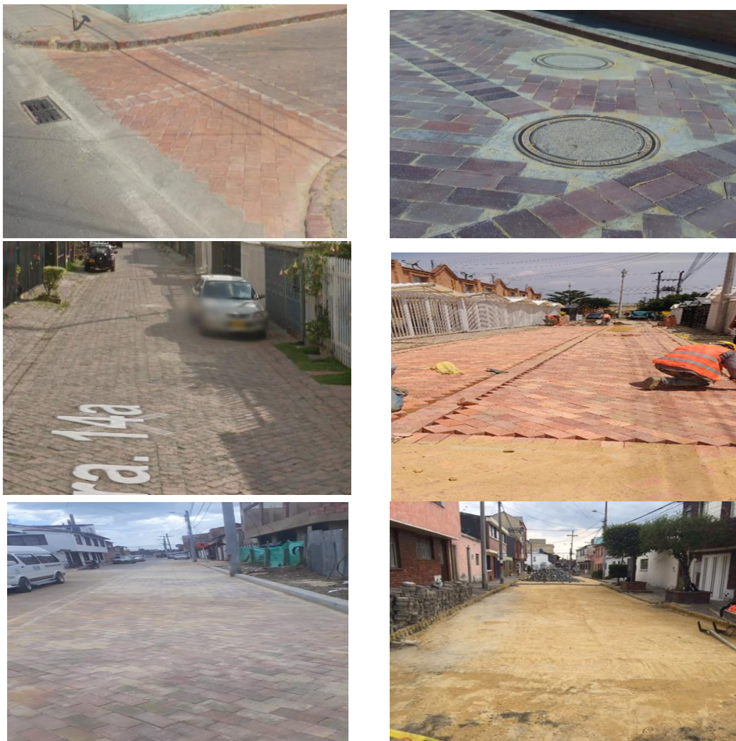
IMAGEN 78. MANTENIMIENTO DE VÍAS ADOQUINADAS EN EL MUNICIPIO DE CHÍA, CONTRATOS DE OBRA NO 393 DE 2016, 449 DE 2017 Y 536 DE 2018
