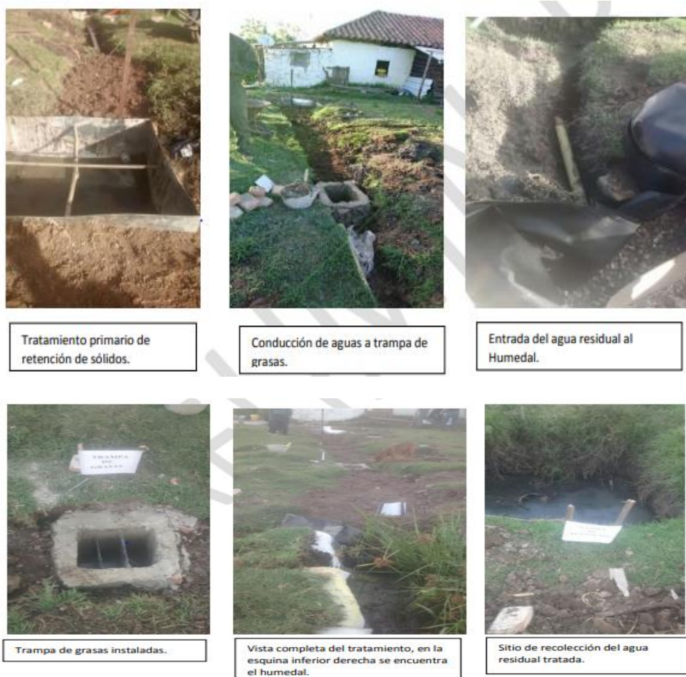
IMAGEN 118. PROCESOS TRATAMIENTO DE SÓLIDOS Y AGUAS RESIDUALES
