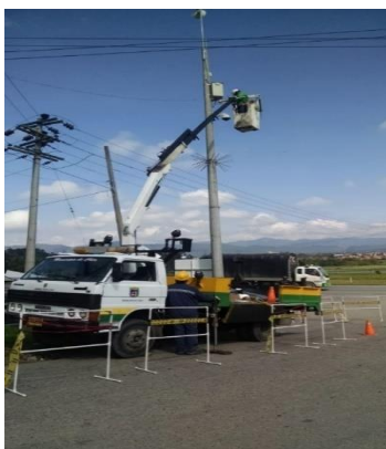
IMAGEN 137. MANTENIMIENTO DE CÁMARAS
