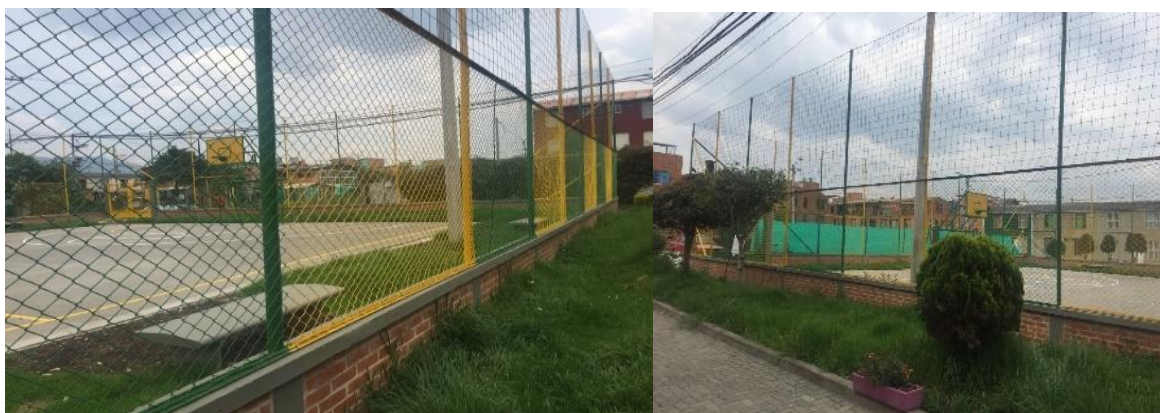
IMAGEN 91. CERRAMIENTO CANCHAS NUEVO MILENIO
