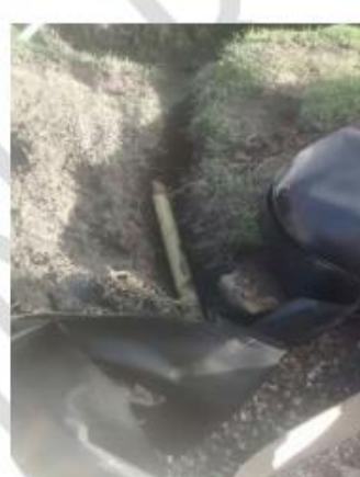
Entrada del agua residual al Humedal.
