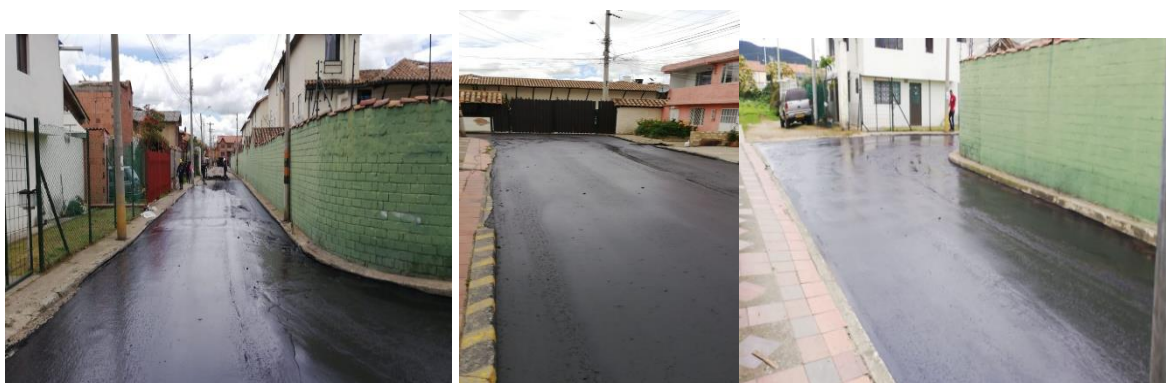
IMAGEN 84. SLURRY 1RA CAPA CRA 5 DE AV PRADILLA HACIA LA CALLE 19. SECTOR PATACOS. (257MT)
