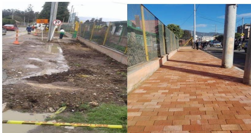
IMAGEN 106. CONSTRUCCIÓN DE ANDÉN FRENTE AL POLIDEPORTIVO EL NISPERO, CON BANCO DE MAQUINARIA, BANCO DE MATERIALES Y PERSONAL OPERARIO
