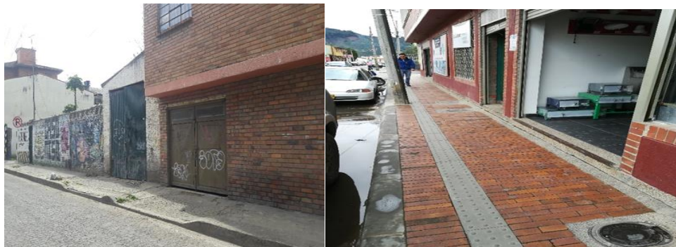
IMAGEN 104. CONSTRUCCIÓN, REHABILITACIÓN Y MEJORAMIENTO DE LOS ANDENES DE LA CARRERA 11 ENTRE CALLES 15 Y 17; CALLE 14 ENTRE CARRERA 10 Y 11, CONTRATO DE OBRA NO 596 DE 2017
