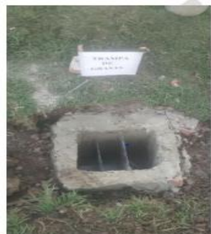
Trampa de grasas instaladas.
