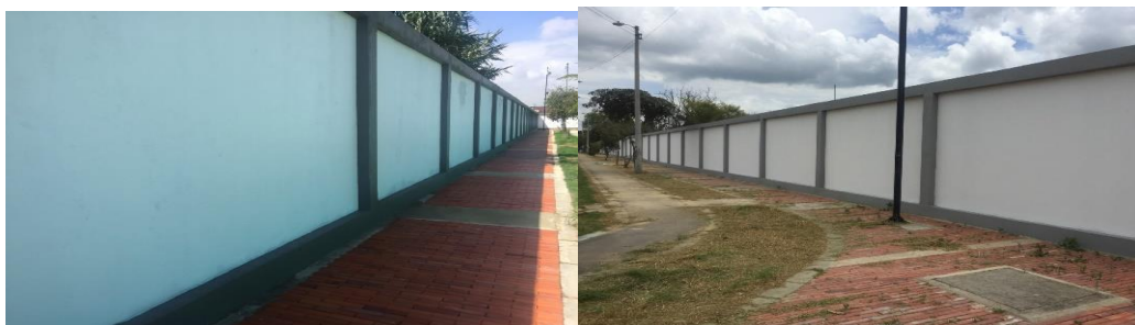
IMAGEN 94. CERRAMIENTO PARQUE EL PARAÍSO
