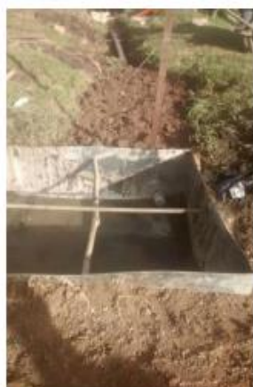
Tratamiento primario de retención de sólidos.
