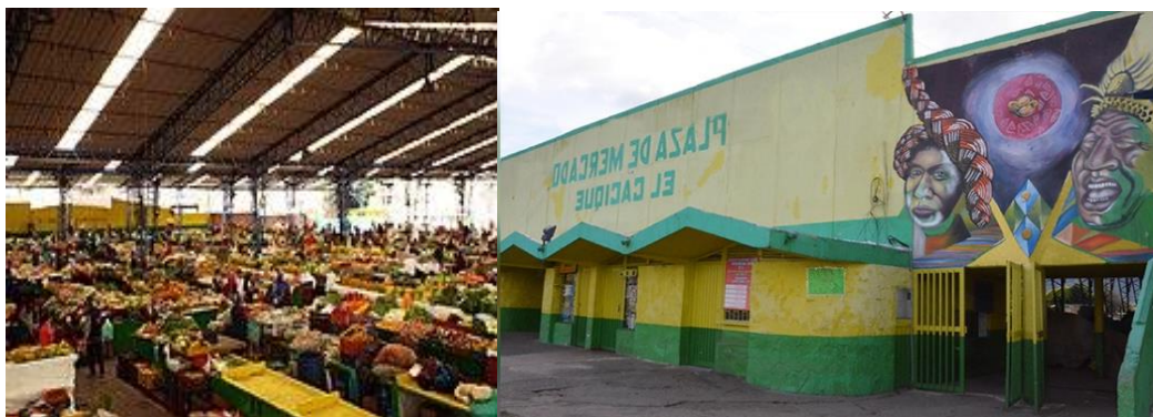
IMAGEN 64. MEJORAS INFRAESTRUCTURA PLAZA DE MERCADO
