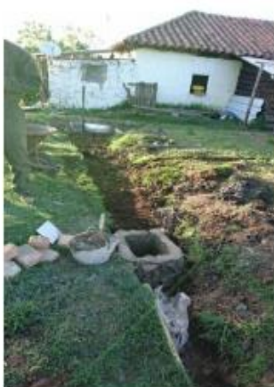
Conducción de aguas a trampa de grasas.
