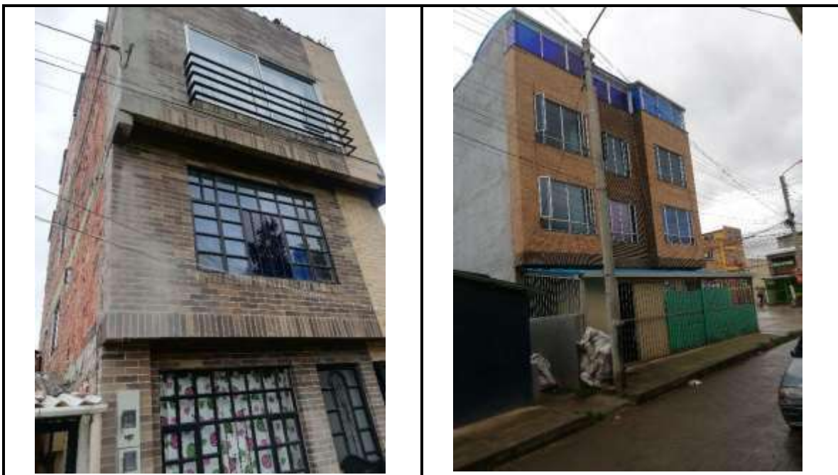
Ilustración 11. Viviendas de características atípicas, sin condiciones de precariedad aparentes y con mejores condiciones de estructura y fachada
