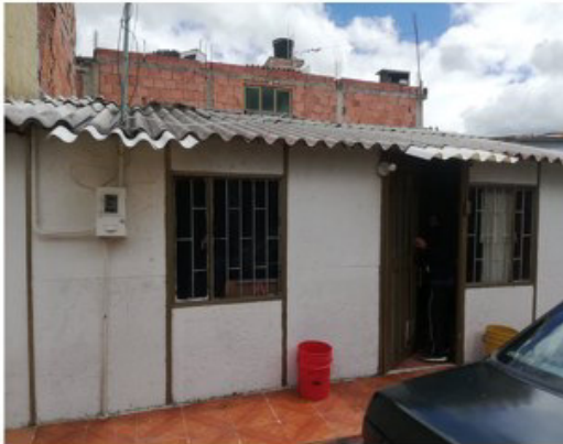
-Tipología un nivel adosado prefabricado
