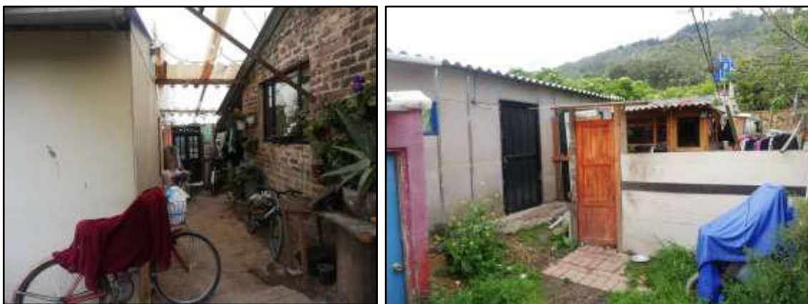
Imagen 5. Edificaciones en condiciones de precariedad
