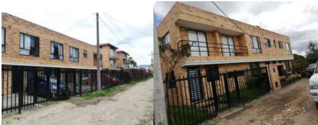
Imagen 4. Edificaciones residenciales atípicas en mejores condiciones de estructura y fachada
