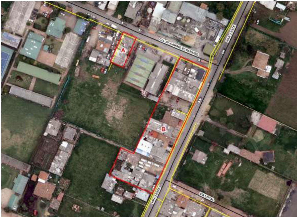
Ilustración 17. Redes de gas domiciliario
