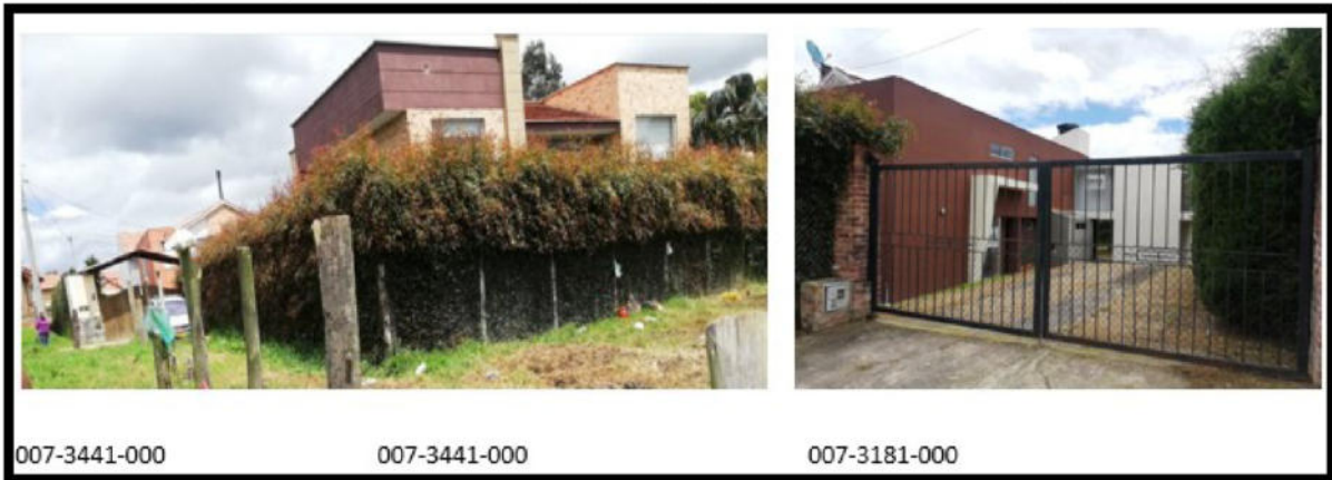
Imagen 5. Edificaciones residenciales atípicas en mejores condiciones de estructura y fachada
