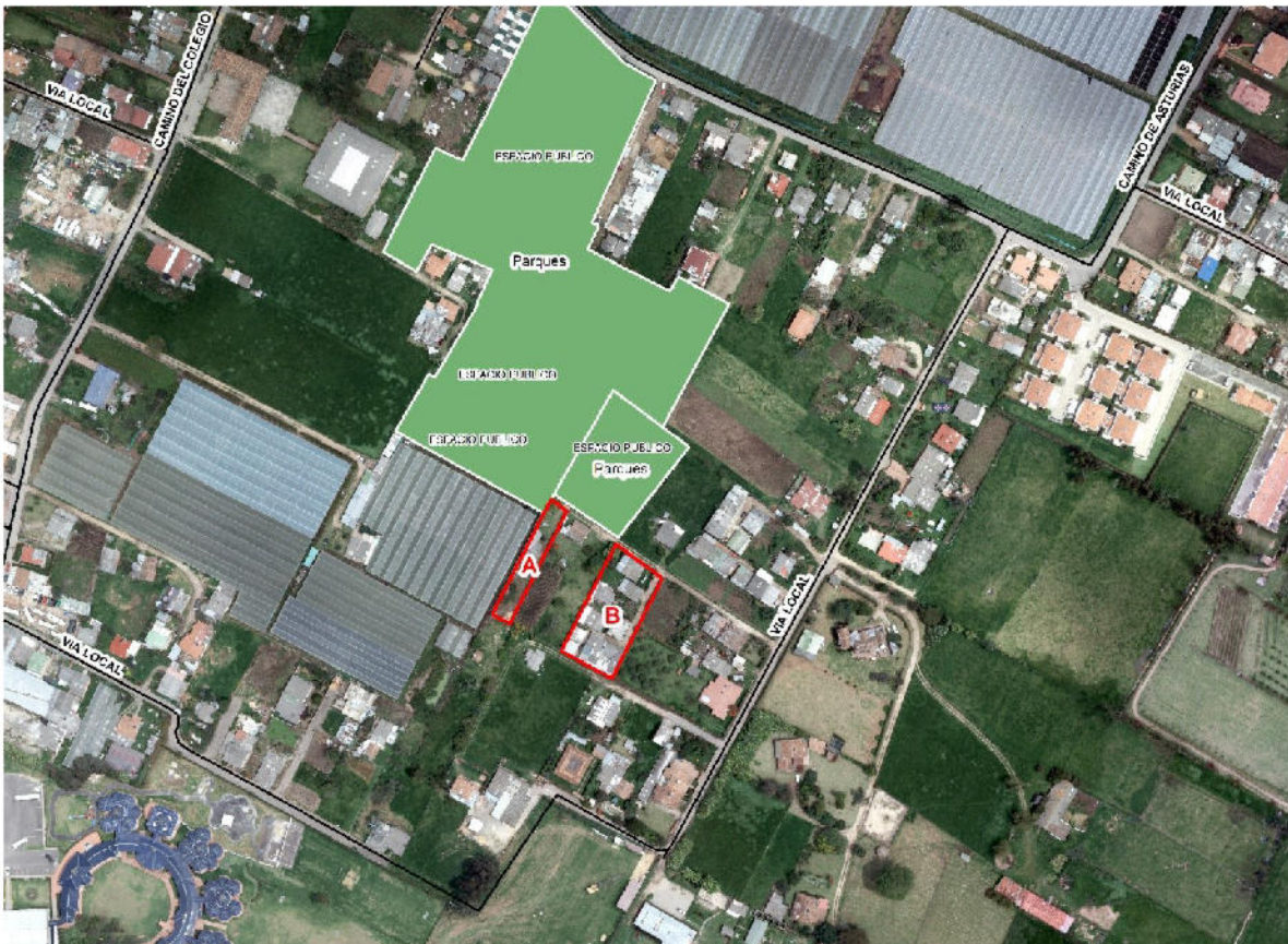
Ilustración 20. Fotografía de espacio público efectivo frente al asentamiento y ubicación de espacios públicos en el entorno cercano según ArcGIS.
