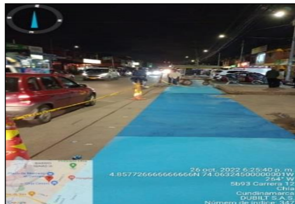
Construcción de ciclorruta Carrera 12
