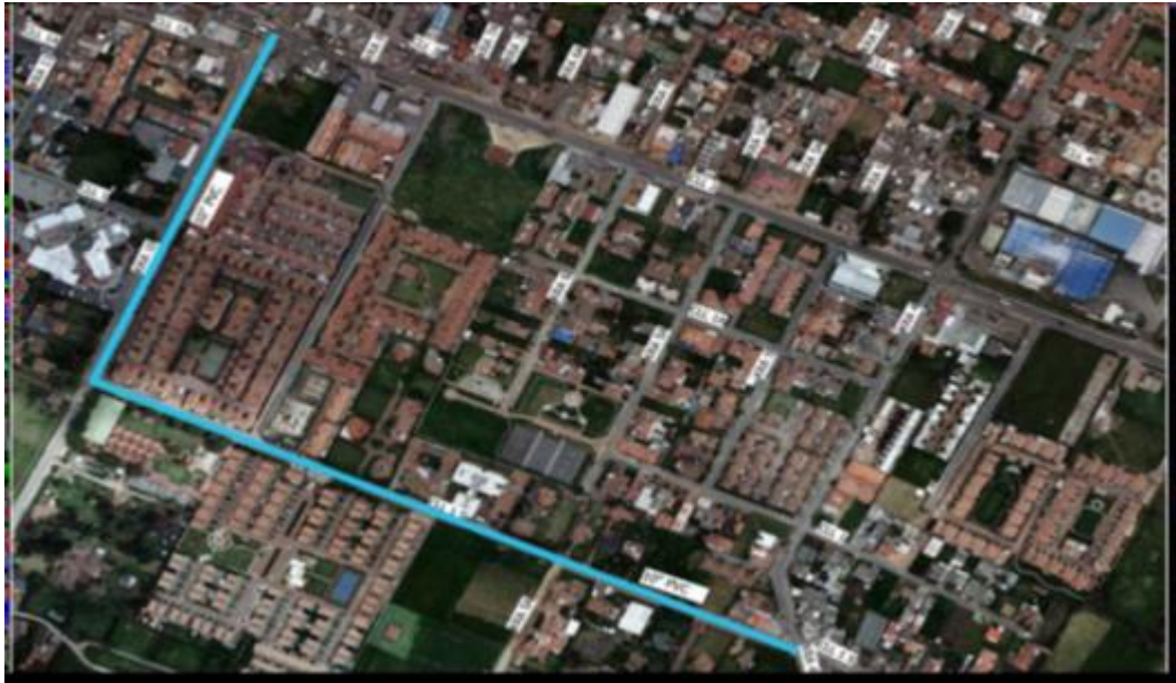
Construcción y ampliación de la red de acueducto en la zona sur (Cra 10 entre variante Chía – Cota y Cl 1 sur entre carrera 4 Carrera 10) del municipio de Chía, Cundinamarca.
