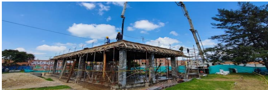
Construcción Ludoteca Barrio el Cairo
