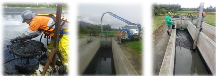
Limpieza estructuras preliminares y difusores de lagunas
