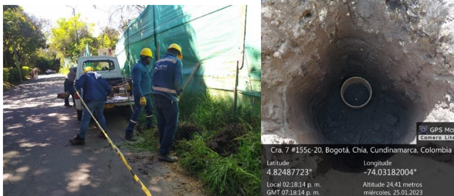
Toma de apiques en diferentes sectores viales le Municipio de Chía
