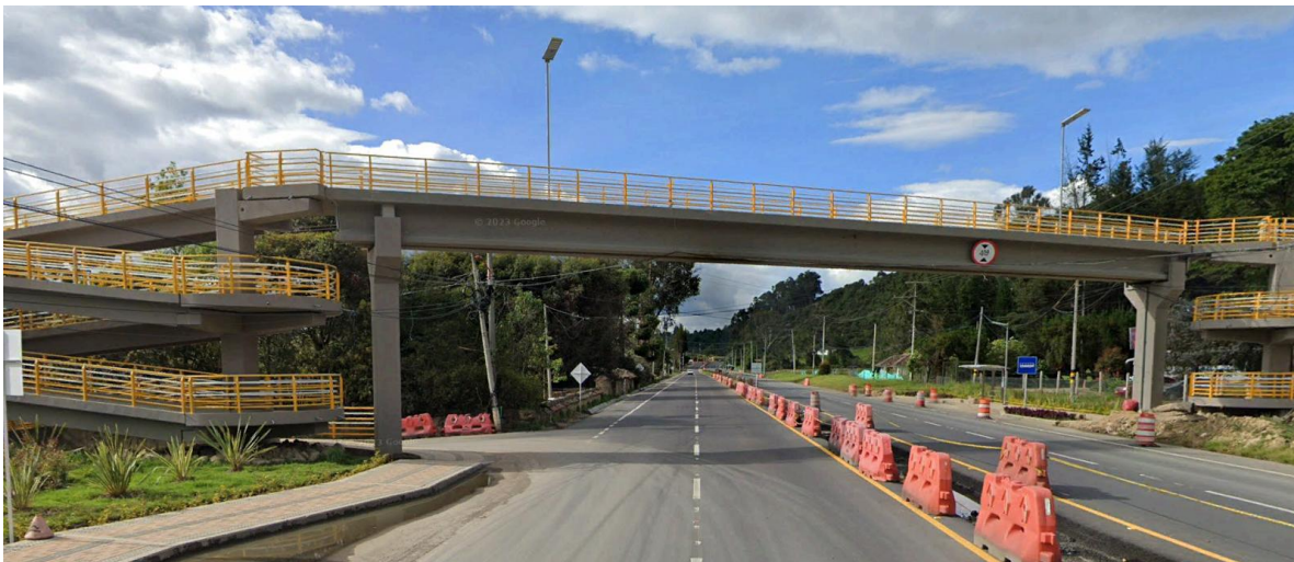
Figura 6 Infraestructura peatonal y biciusuarios
