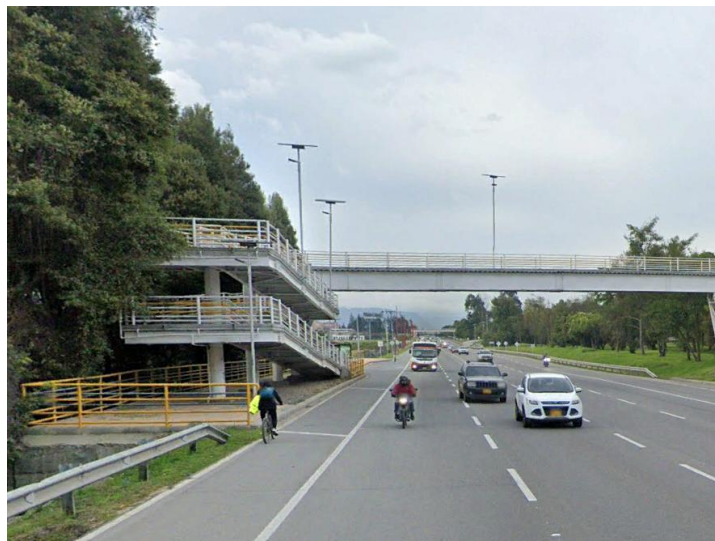
Figura 6 Infraestructura peatonal y biciusuarios
