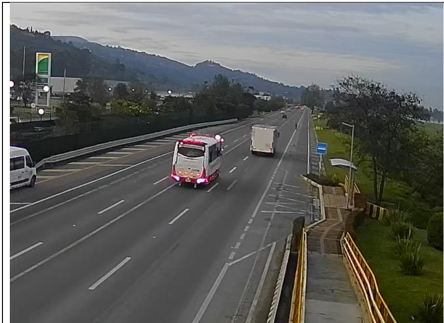
Calzada occidental NS
