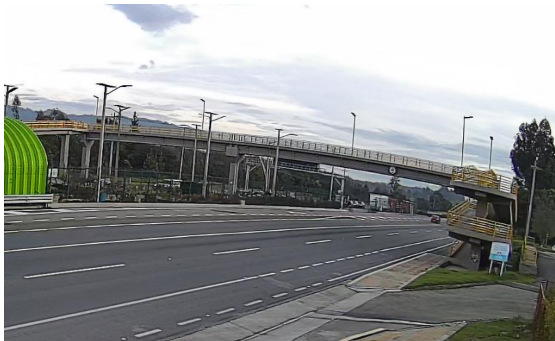
Figura 8 Infraestructura peatonal y biciusuarios
