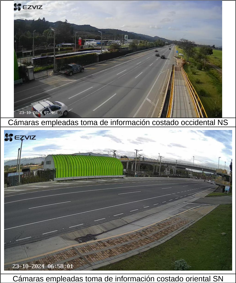
Figura 2 Cámaras utilizadas para la toma de información e instalación
