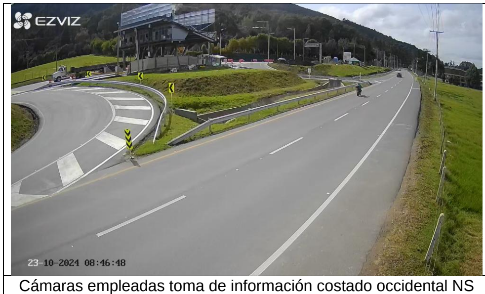
Figura 2 Cámaras utilizadas para la toma de información e instalación
