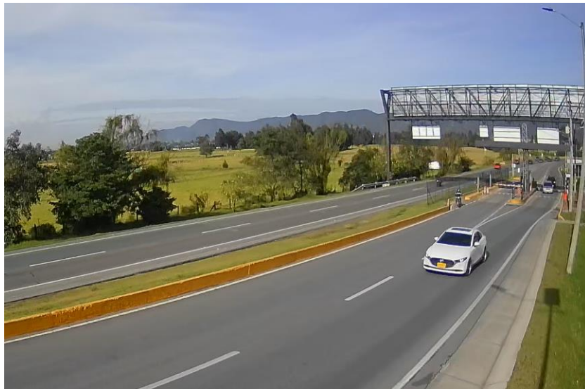
Figura 2 Cámaras utilizadas para la toma de información e instalación
