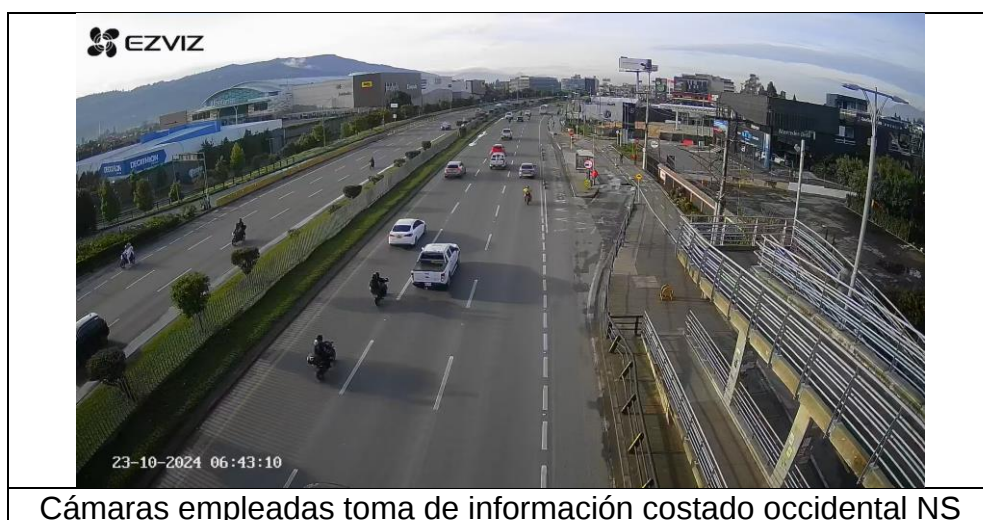
Figura 2 Cámaras utilizadas para la toma de información e instalación
