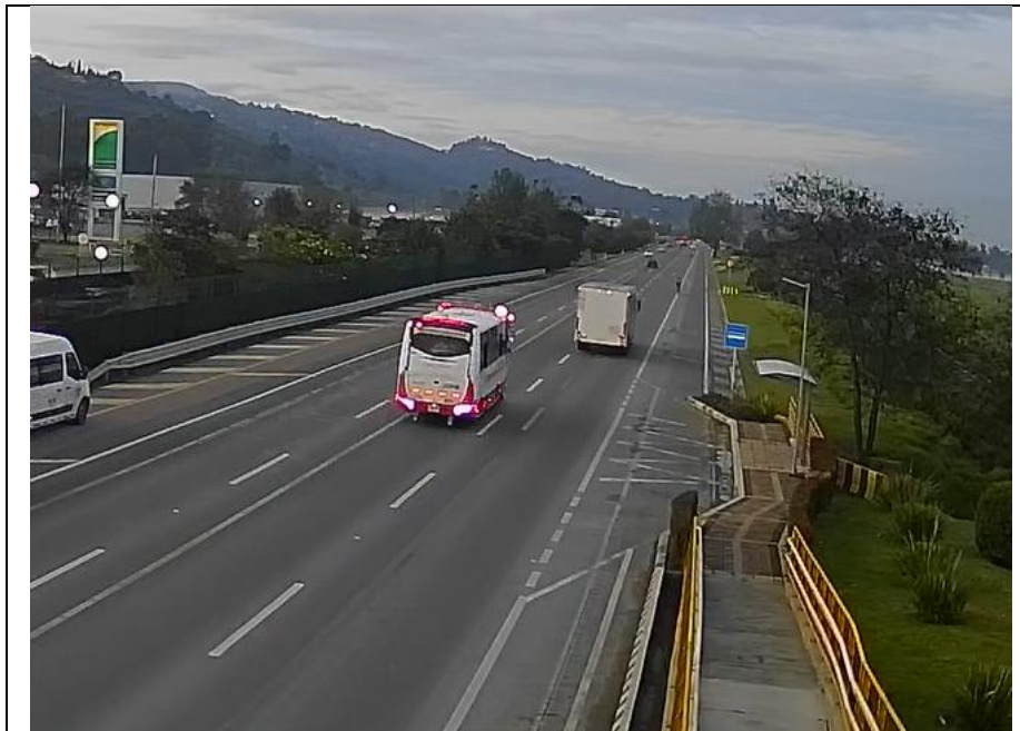
Calzada occidental NS
