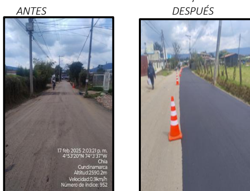
Fuente: registro fotográfico Secretaría de Obras Públicas
