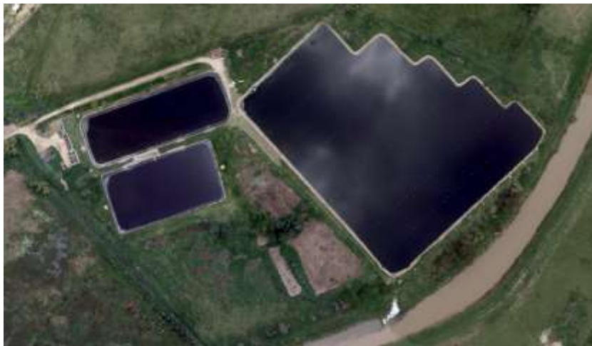
Ilustración 87. Planta de tratamiento de aguas residuales PTAR Chía 1. Fuente Emserchía enero 2016.
