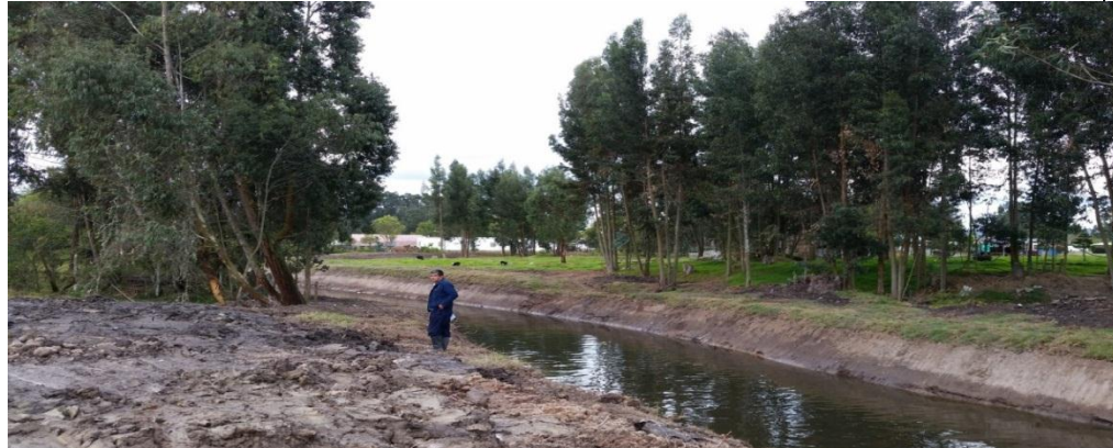
Fotografía: Intervención de limpieza del río Frío, cerca del puente de Guanata en Julio de 2015.
