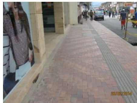
ILUSTRACIÓN 26 RECONSTRUCCIÓN DE ANDENES. FUENTE SOP
