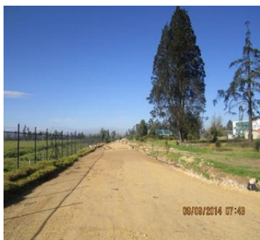
ILUSTRACIÓN 29 OBRA CRA 5 ENTRE CALLES 19 Y AV. PRADILLA FUENTE SOP
