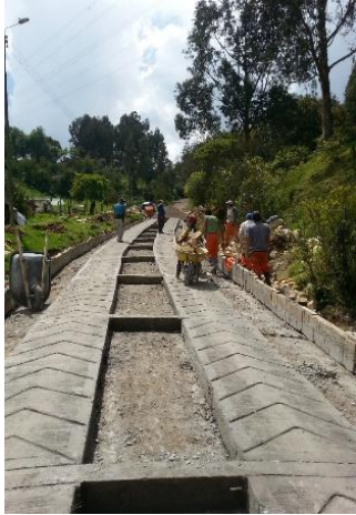
ILUSTRACIÓN 28 INSTALACIÓN DE PLACA HUELLA VÍA LA VALVANERA. FUENTE SOP
