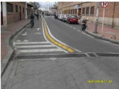
ILUSTRACIÓN 25 CONSTRUCCIÓN DE CICLO VÍA. FUENTE SOP
