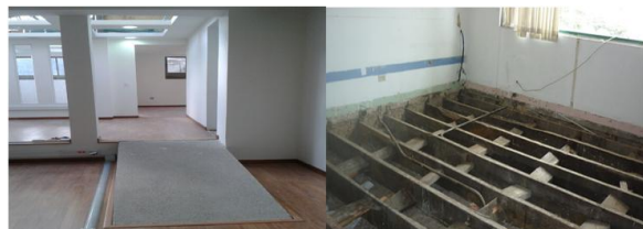
ILUSTRACIÓN 17 OBRAS ESTRUCTURALES. EDIFICIO PRINCIPAL ALCALDÍA. FUENTE SOP
